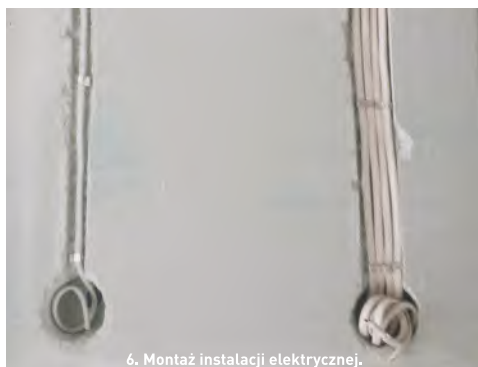
6. Montaż instalacji elektrycznej.
