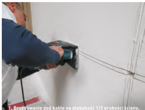
1. Bruzdowanie pod kable na głębokość 1/3 grubości ściany.
