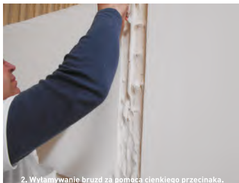
2. Wytłamywanie bruzd za pomocą cienkiego przecinaka.
