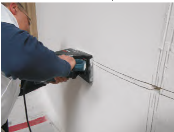
3. Bruzdowanie pod kable na głębokość 1/3 grubości ściany.
