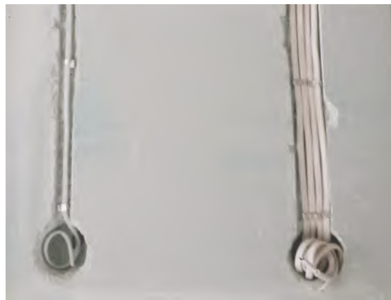
8. Montaż instalacji elektrycznej.
