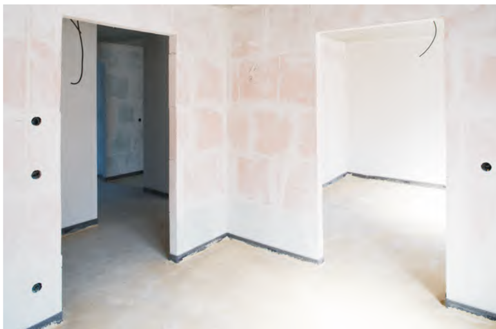
Rys.11. Prawidłowe rozmieszczenie płyt w strefie ponad otworem drzwiowym.
