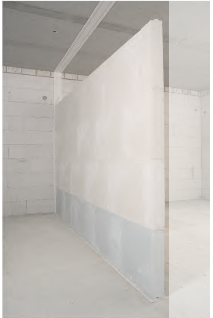
Wykonanie połączenia elastycznego z wykorzystaniem taśmy AkustikPro
