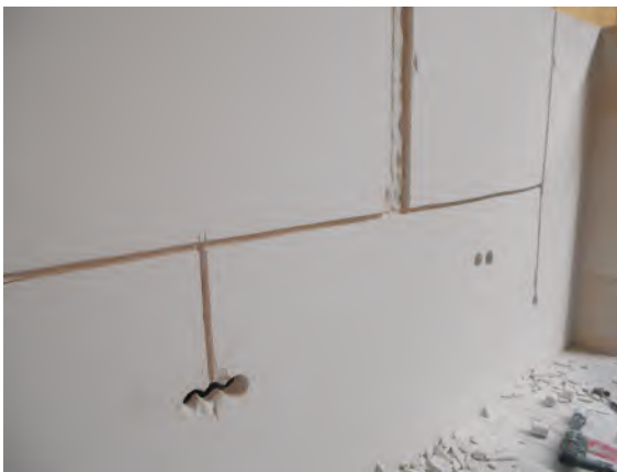
7. Przygotowana ściana do montażu instalacji elektrycznej po bruzdowaniu.
