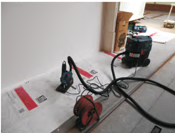
1. Potrzebne narzędzia/sprzęt: bruzdownica, odkurzacz, wiertarka, otwornica do puszek.
