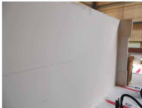
2. Trasowanie ściany pod instalacje elektryczne.
