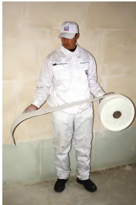
Wykonanie połączenia elastycznego z wykorzystaniem taśmy AkustikPro
