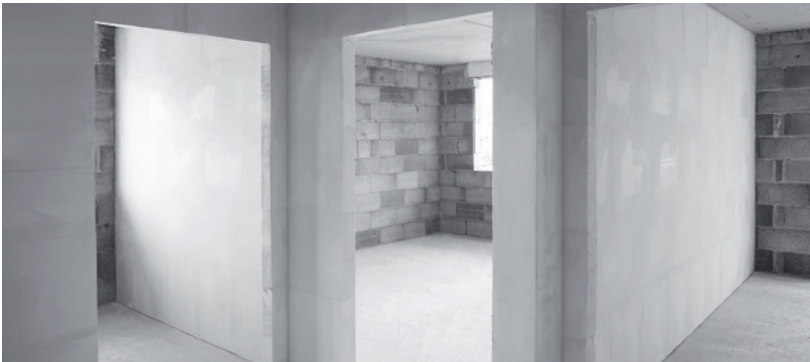
Rohbaubegleitender Einbau von Gips-Wandbauplatten
