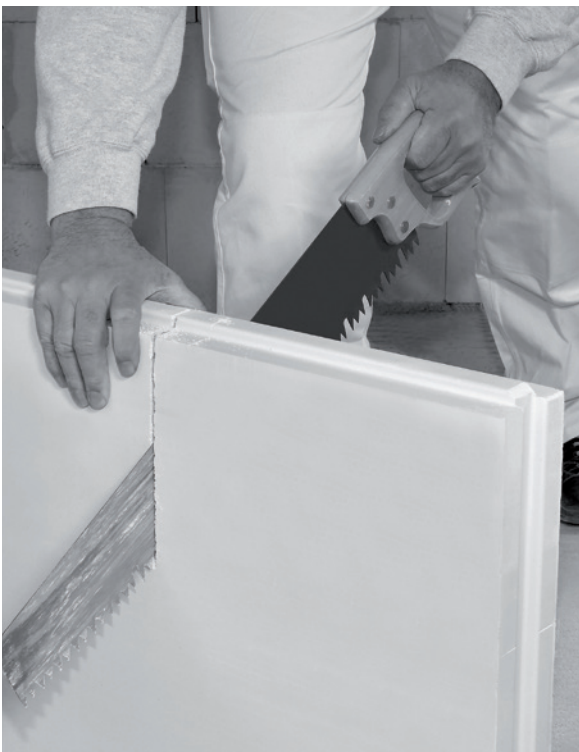
Rohbaubegleitender Einbau von Gips-Wandbauplatten
