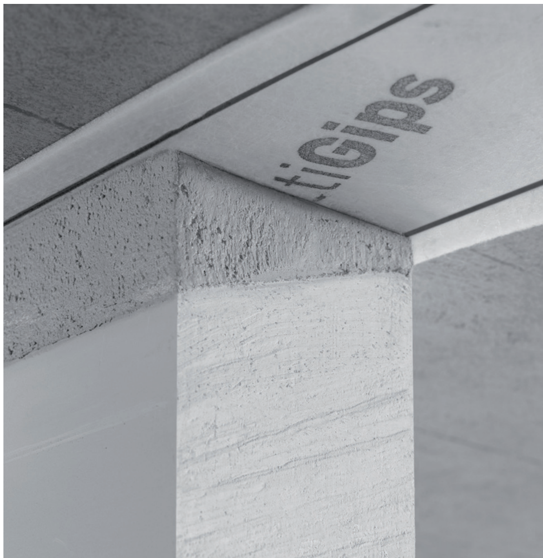
Elastischer Anschluss mit MultiGips AkustikPro 120-3
