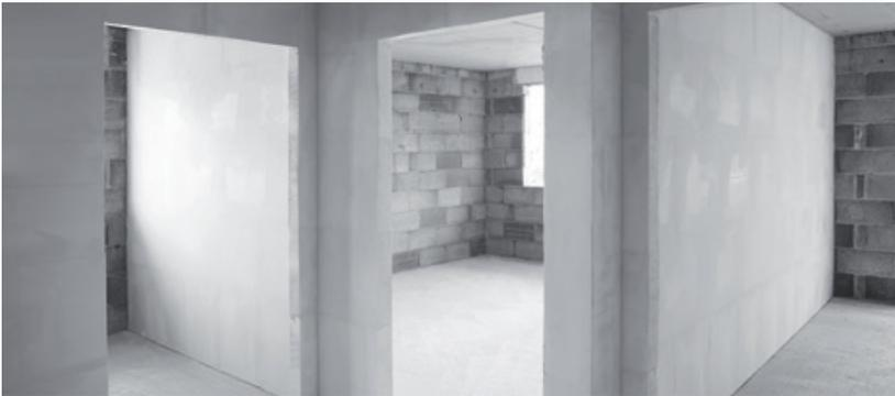
Rohbaubegleitender Einbau von Gips-Wandbauplatten
