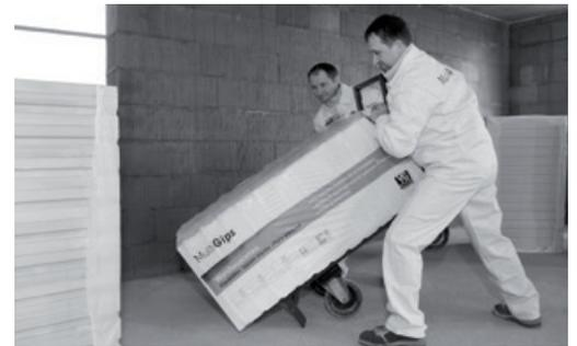
Die rohbaubegleitende Ausführung von Gips-Wandbauplatten beginnt mit einer überlegenen Hochlogistik. Dabei werden die Plattenpakete auf den Geschossebenen mit Hochkran abgesetzt – außerhalb oder innerhalb von Gebäuden. Entladungen durch Fensteröffnungen bis zu einer Brüstungshöhe von 17,5 m sind machbar. Die Pakete werden mit Plattenwagen direkt am Einbauort platziert und sofort verarbeitet.
