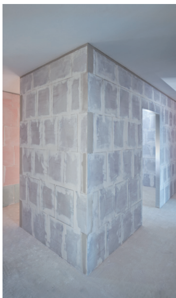
Trennwände aus massiven Gips-Wandbauplatten verbinden klare Raumbildung im Rohbau mit ästhetischem Raumempfinden im Finish
