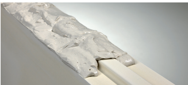
Abb. 9: Auftrag von Gipskleber zum Verbinden von Gips-Wandbauplatten
