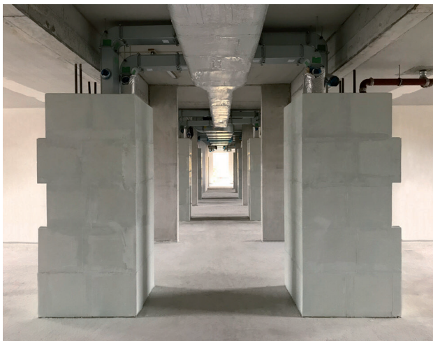
Abb. 14: Schachtverschluss mit Gips-Wandbauplatten mittlerer Rohdichte
