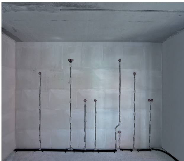
Abb. 17: Sachgemäße Schlitzbildung mit Mauerfräse
