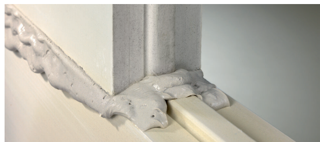
Abb. 10: Gipskleber aufnehmen und Fugen damit verschließen
