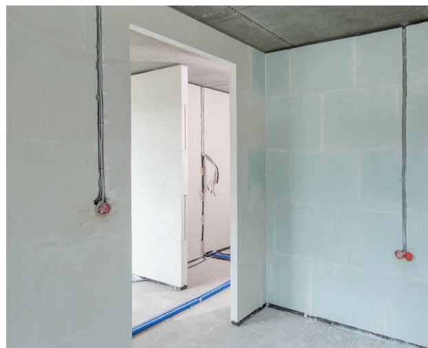
Abb. 4: Gips-Wandbauplatten für die flächeneffiziente Raumbildung; hydrophobiert (bläulich) für häusliche Feuchträume
