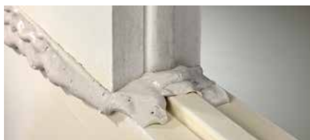
Abb. 10: Gipskleber aufnehmen und Fugen damit verschließen
