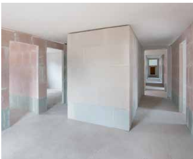
Abb. 5: Gips-Wandbauplatten mit hoher Rohdichte (rötlich) für verbesserten Schallschutz; erste Reihe mit Hydrophobierung
