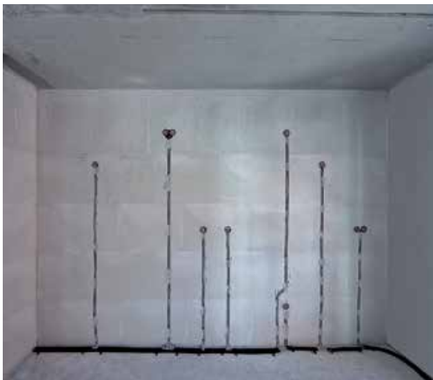
Abb. 17: Sachgemäße Schlitzbildung mit Mauerfräse, z.B. Spit F40
