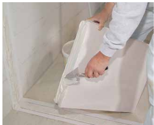
Abb. 8: Randanschlussstreifen fixieren, Kleber auftragen, Platten flucht- und lotrecht setzen, dicht stoßen
