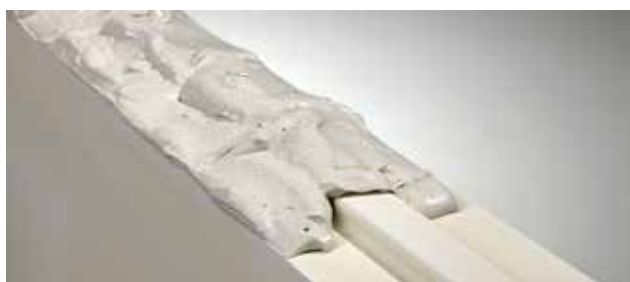
Abb. 9: Auftrag von Gipskleber zum Verbinden von Gips-Wandbauplatten
