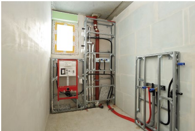
Bild 4. IBP-Eignungsnachweis für Installationswand aus Gips-Wandbauplatten, flächenbezogene Masse ca. 122 \text{ kg/m}^3 , in Verbindung mit Vorwandtechnik von TECEprofil (Fotos: Multigips)
