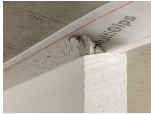
Bild 3. Bauakustische Entkopplung einer Trennwand aus Gips-Wandbauplatten mit normenkonformem Randanschlussstreifen aus PE-Schwerschaum, Fugenverschluss zur Decke in Ausführung
