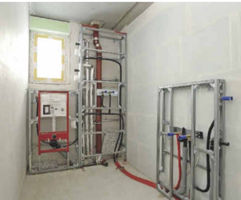
Vorwandtechnik: Trockenbau und industriell vorgefertigte Sanitärwände sorgen für reduzierte Bauzeiten, Kalkulationssicherheit und vereinfachte Koordination der Gewerke. Bilder: Tece
