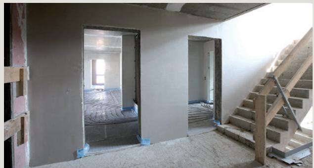
Die Oberflächen in den Treppenhäusern erreichen mit MultiGips MP Classic D6 eine deutlich erhöhte Druckfestigkeit  $\geq 6,0 \text{ N/mm}^2$ . Etwa das Dreifache des in der Norm geforderten Wertes für Gips-Trockenmörtel, die allgemeinen Anforderungen genügen müssen! Der widerstandsfähige Putzfestkörper mit erhöhter Oberflächenhärte schützt die stärker begangenen Treppenhäuser vor Verschleiß, Abrieb und mechanischer Beschädigung.
