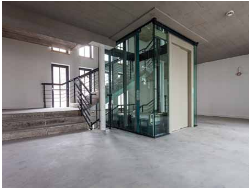
Alt trifft neu im Treppenhaus: Während die Treppenarchitektur und die Decke noch ganz klar auf die Herkunft des Gebäudes verweisen, repräsentieren der Aufzug und die verputzten Wände den Beginn einer neuen Nutzungsphase in Prora.
