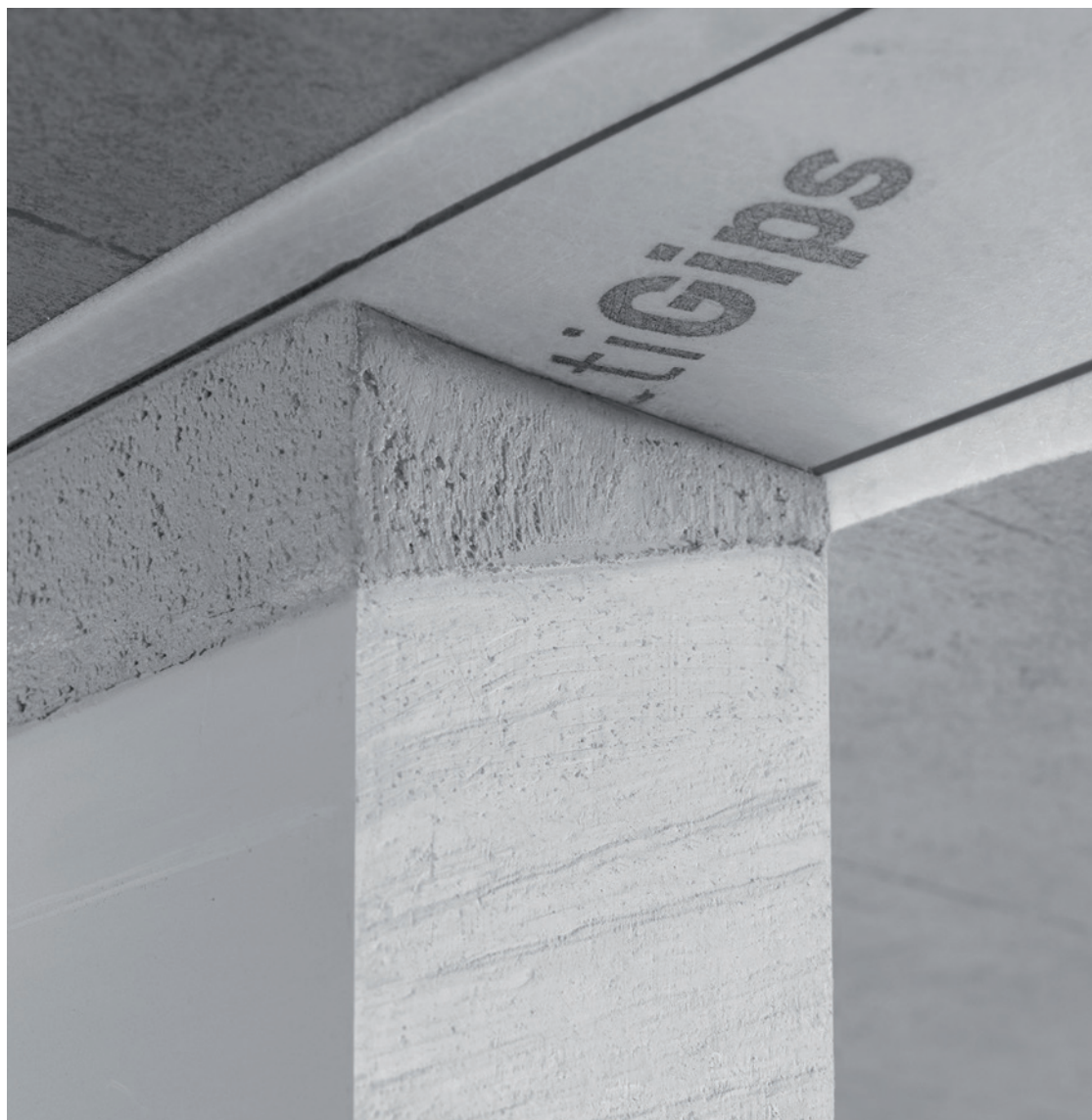
Elastischer Anschluss mit MultiGips AkustikPro 120-3
