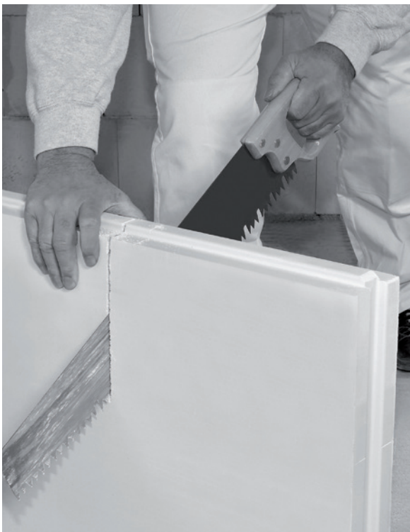
Rohbaubegleitender Einbau von Gips-Wandbauplatten
