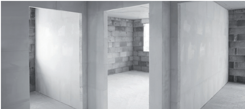
Rohbaubegleitender Einbau von Gips-Wandbauplatten
