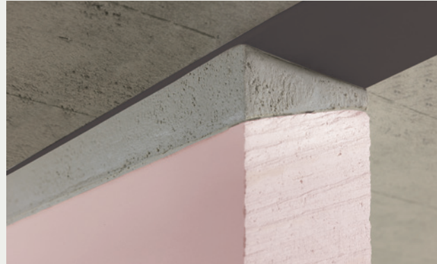
Elastischer Randanschlussstreifen zur Schallentkopplung und barythaltiger Füllgips FG 70-B für die Deckenfuge
