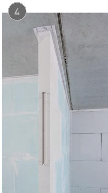
Gips-Wandbauplatten werden mit Randanschlussstreifen elastisch angeschlossen. Ihre Entkopplung reduziert die Körperschallübertragung deutlich. Deshalb bestätigt die HFT Stuttgart, dass zur Reduzierung der Installationsgeräuschübertragung nicht nur massive Installationswände mit 220 kg/m<sup>2</sup> nach DIN 4109, sondern auch leichte Gips-Massiv-Wände geeignet sind ...
