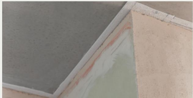
*Optimierte Stoßstellendämmung mit Randanschlussstreifen: Elastisch angeschlossene Trennwände aus Gips-Wandbauplatten belasten nicht die Schallschutzleistung der trennenden Decke.*
