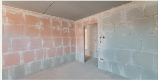
*Schallschutzplatten für Wohnräume (links) und hydrophobierte Gips-Wandbauplatten für häusliche Küchen und Bäder.*
