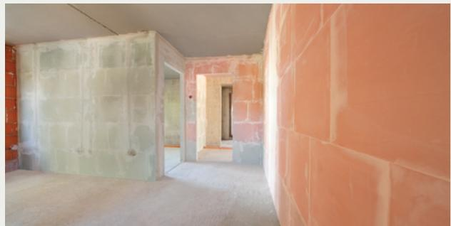
*Trennwände mit vergleichsweise geringen flächenbezogenen Massen, die im Sinne des Nationalen Anhangs zu DIN EN 1991-1-1 nicht als einzelne Linienlasten berücksichtigt werden müssen.*
