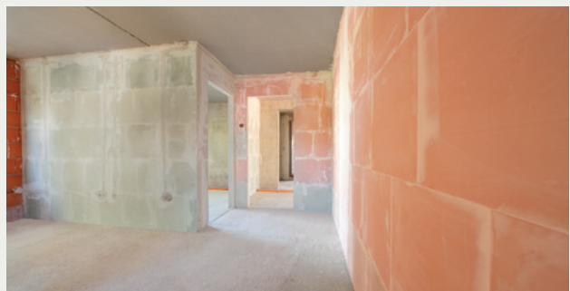
Trennwände mit vergleichsweise geringen flächenbezogenen Massen, die im Sinne des Nationalen Anhangs zu DIN EN 1991-1-1 nicht als einzelne Linienlasten berücksichtigt werden müssen.
