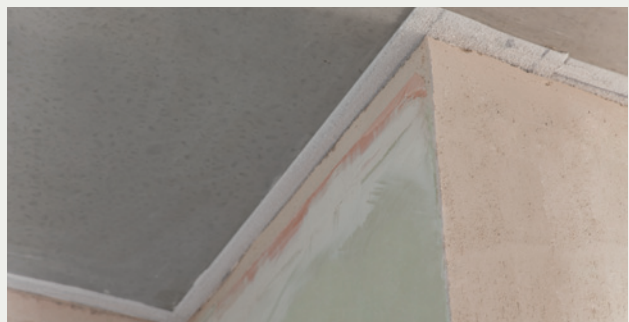
Optimierte Stoßstellendämmung mit Randanschlussstreifen: Elastisch angeschlossene Trennwände aus Gips-Wandbauplatten belasten nicht die Schallschutzleistung der trennenden Decke.
