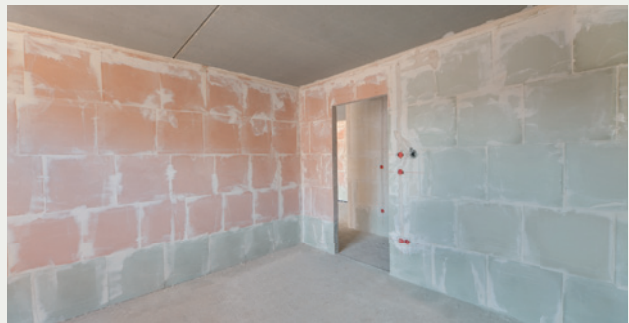
Schallschutzplatten für Wohnräume (links) und hydrophobierte Gips-Wandbauplatten für häusliche Küchen und Bäder.
