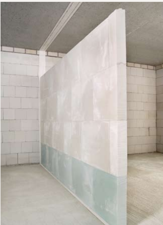
Der elastische Anschluss bei Gips-Massiv-Wänden an angrenzende Bauteile ist nach DIN 4103-2 geregelt. Der Schwerschaumstreifen MultiGips AkustikPro 120 gewährleistet die akustische Entkoppelung.
