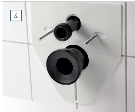
Entkopplung von keramischen Belägen und WC-/Bidet-Keramik
