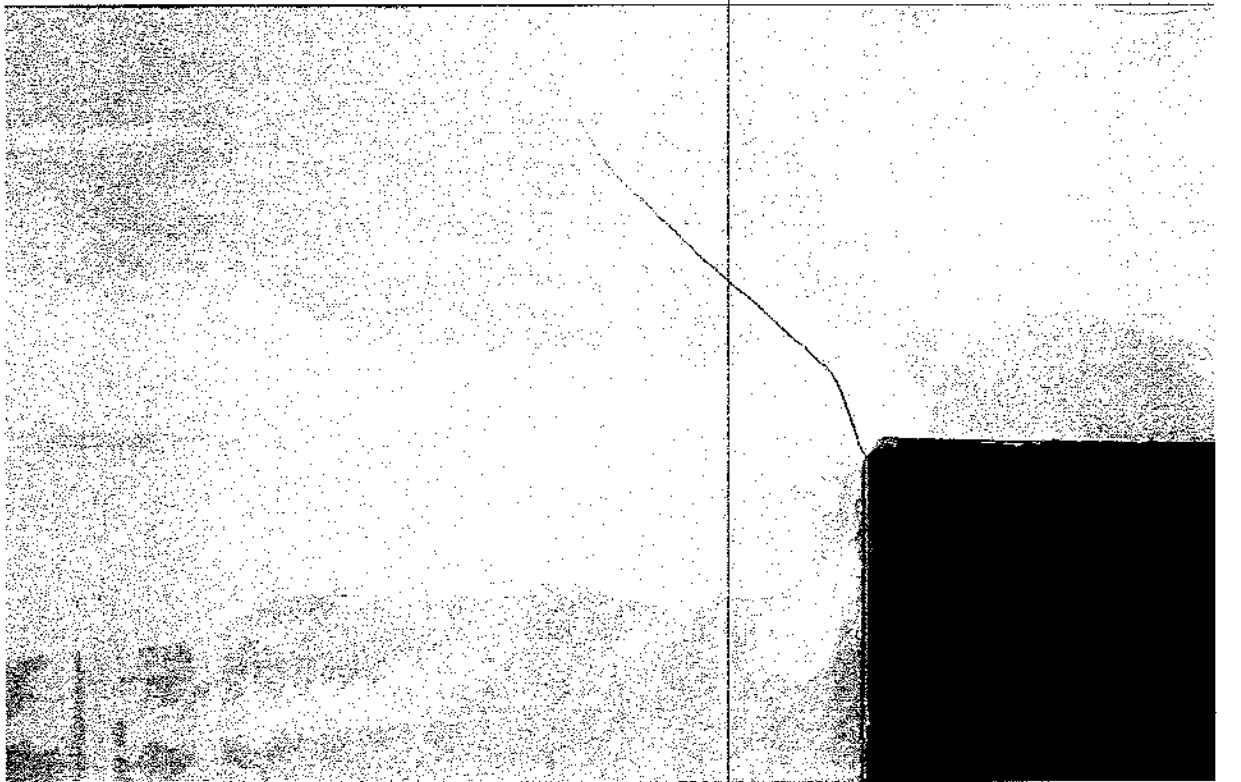
Bild A.13.1: Riss in Achse C in der Ecke des Türsturzes, Wand 2.3.
