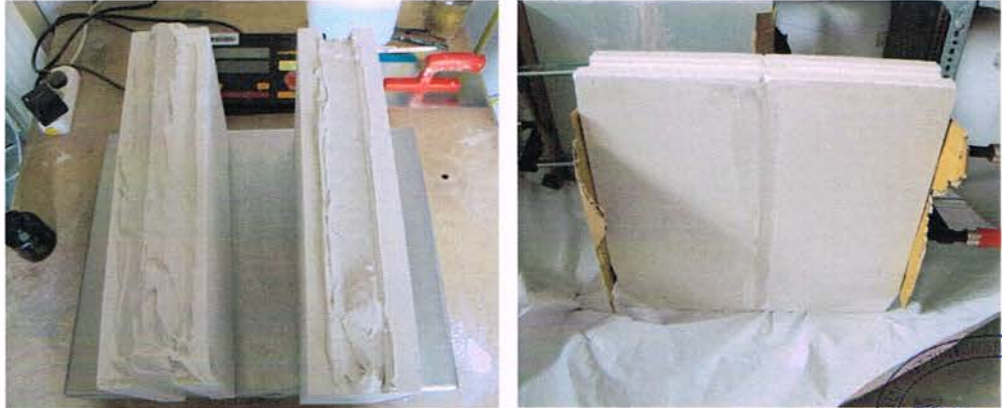
Bild 2: Verkleben der zugeschnitten Gipswandbauplatte.
