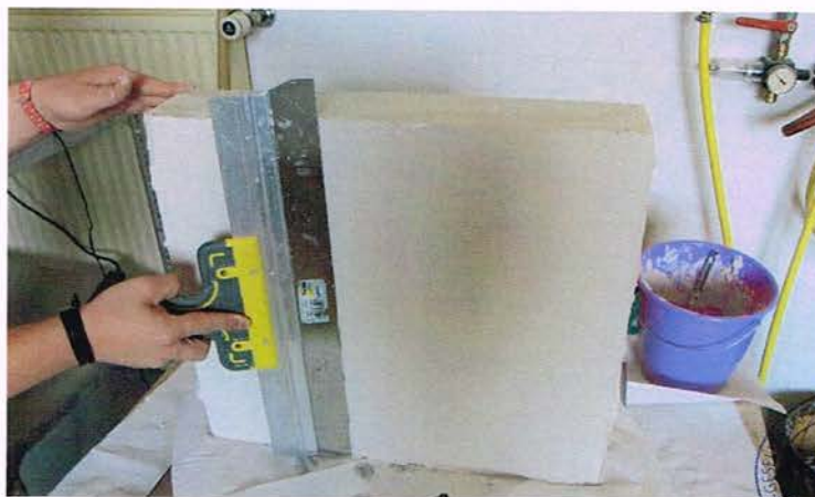
Bild 3: Verspachteln der Gipswandbauplatte.
