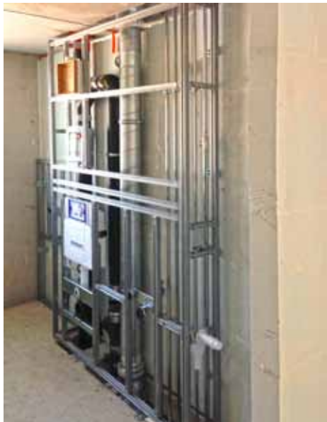
Raumhohes Vorwand- installationsystem an einer Installationswand aus massiven Gips- wandbauplatten Fotos: VG-Orth
