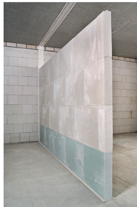
Elastische Randanschlussstreifen (rechts) sorgen für die bauakustische Entkopplung
