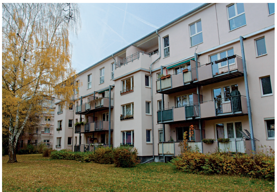
Nachher: Ein Wohnblock mit zusätzlichem vierten Geschoss
