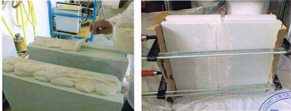
Bild 2: Verkleben der zugeschnitten Gipswandbauplatte.
