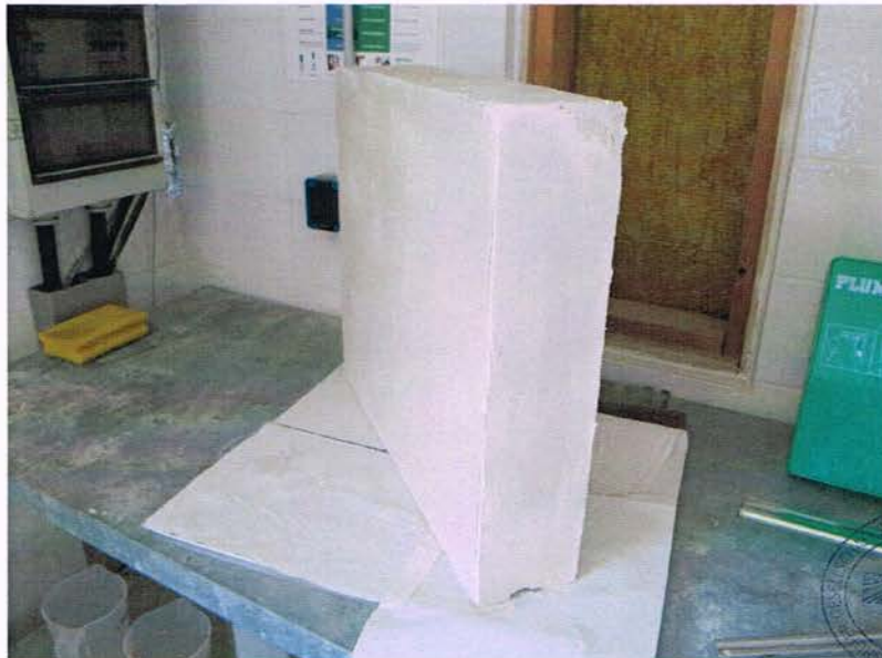
Bild 3: Verspachteln der Gipswandbauplatte.
