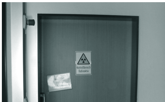
Beispiel einer Seilo® Strahlenschutztür, hier als Schiebetür mit 2,5 mm Bleieinlage und Schichtstoffoberfläche
