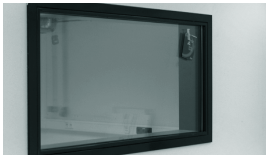
Sichtfenster mit Strahlenschutz-Bleiglas wie es in der medizinischen Diagnostik zur Beobachtung des Patienten während der Untersuchung verwendet wird.
