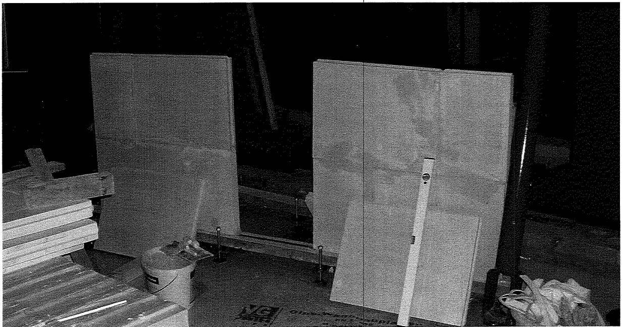
Bild A.10.2: Wand 3 im Aufbau.
